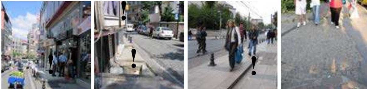
人行道在不同平面，常有通向地下商店的阶梯，增加了行人绊倒的风险。因材料劣质且疏于维护，路面状况糟糕。不合适的路面拼凑在一起，不易于行走。
