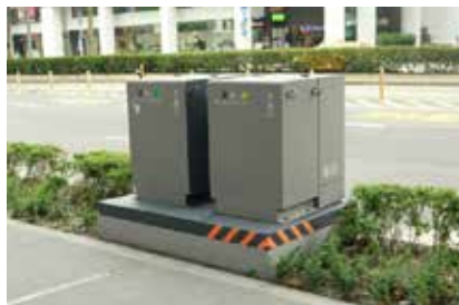
图 3-48 | 台北松江路的变电箱的多箱并集设计案例
