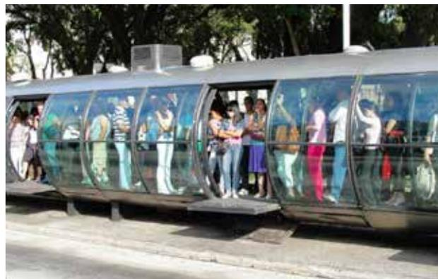
**图 52** 库里蒂巴市BRT系统车站的屏蔽门。在没有公交车辆停靠时，屏蔽门依然处在开放状态。如果车站人流较多，行人则可能不慎从开放的屏蔽门处跌落至公交车道。
