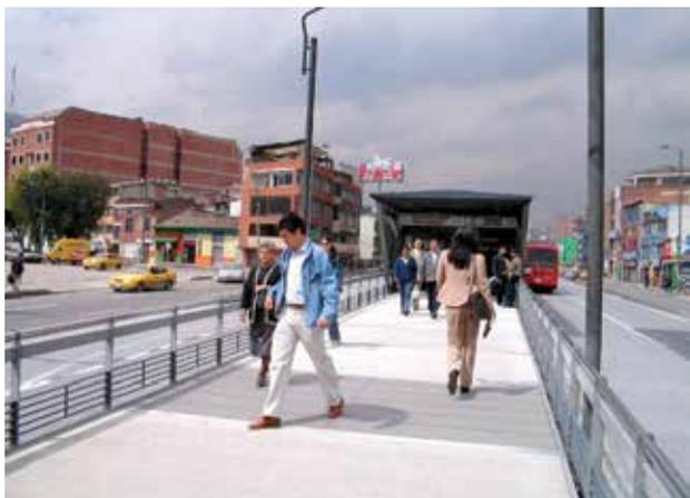
**图 54** TransMilenio系统，2006年：车站上两个分站台之间的通道。图中，通道的护栏仅有1米高左右，很容易被行人翻越，是重大的安全隐患。
