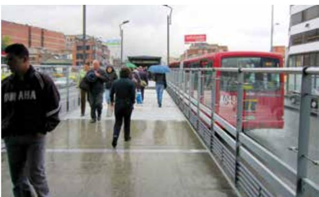
**图 55** TransMilenio系统，2011年：护栏的高度增加了，以防范行人翻越。我们建议为车站上的所有连接通道加装较高的护栏
