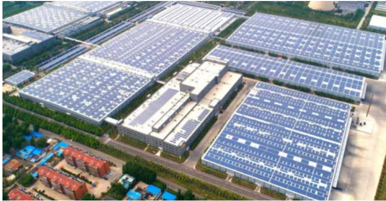
图 2.9 | 10MW分布式光伏在山东省一工业园区屋顶的应用
